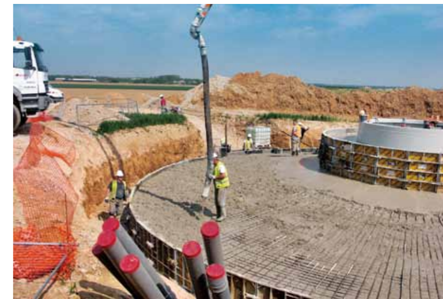
▲ WEA E3 Fundamentguss
