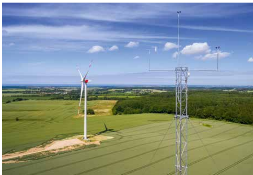
► Messmast am Prototypenstandort Brusow
