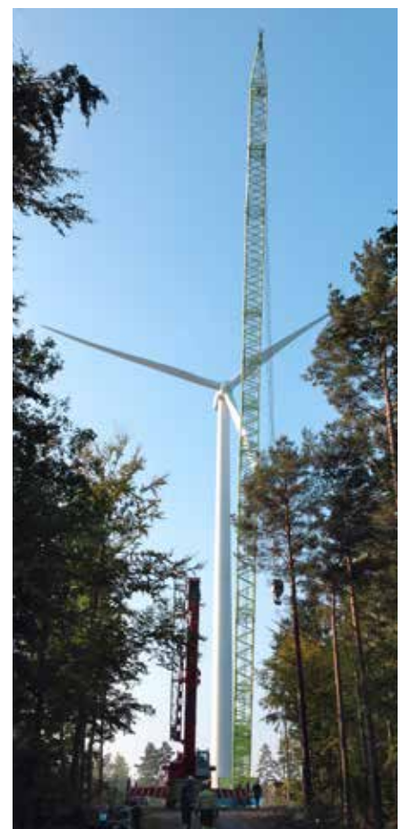
► Errichtung einer eno 100 in Schweden
